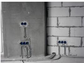
**Не вбивайте** без разрешения жэка или домоуправления гвозди, костыли для подвески штор, картин, полок в квартирах, где электропроводка скрыта в стенах. Прodelывая в стенах отверстия и борозды, вы можете повредить скрытую электропроводку и подвергнуться поражению током.
